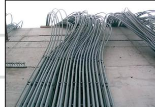
Umfassende Erfahrungen und extreme Sorgfalt sind erforderlich, wenn zur Nutzung der Erdwärme die Sonden gesetzt werden. Eine über Jahrzehnte sichere maximale Ausbeute ist dann sichergestellt.
